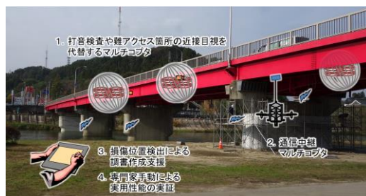
図1. 目視・打音点検をするドローンロボット
