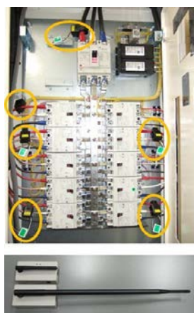
図 3-2 実装した無線センサと受信機
