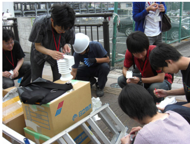
写真 8. 微気象センサネットワーク TScan 設置風景(2009 年 6 月 3 日)
