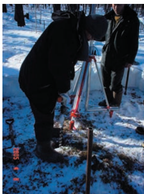
観測機器設置のための永久凍土穿孔
