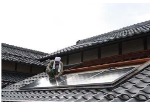
図 60 太陽光発電パネル設置の様子
