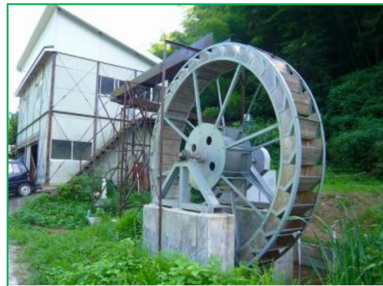
図 2-3-1 水力発電システムの外観
