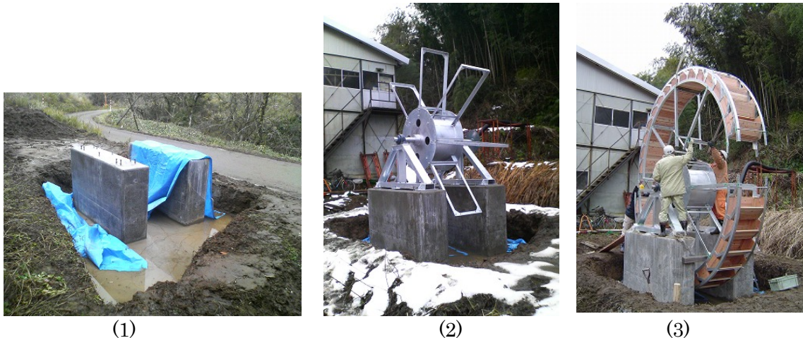
図 3-3-1-8 上掛け水車の組立の過程。(1)基礎工事、(2) 台座、ハブ、アームの組み立てと設置、(3)水車本体（水受け部）の組み立てと設置
