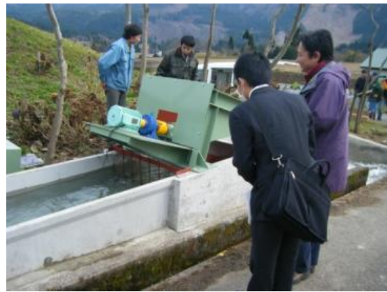
図 2-3-4 住民主体による螺旋水車の設置
