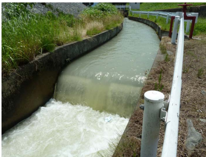
図 3-3-15-2 黒部川扇状地を等高線に直角方向に流れる農業用水路に設置されている落差工（落差：1 m）
