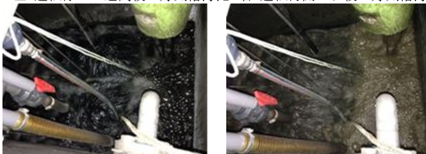
(冬季) 左: 運転停止 1 ヶ月後の好気槽汚泥 右: 運転再開 1 日後の好気槽汚泥
