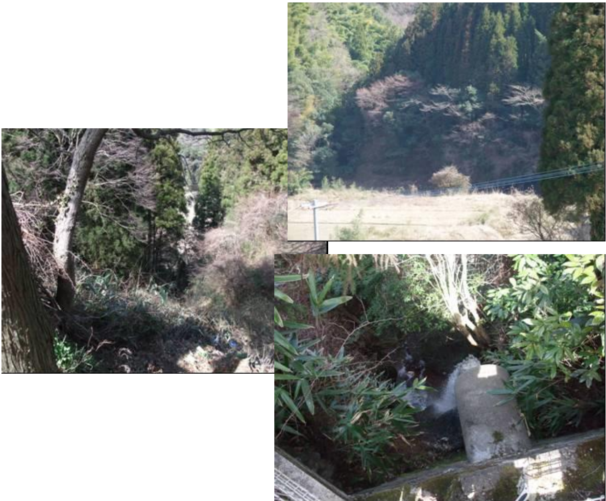
図-18 「長崎」付近の放水地点(右下)と周辺状況(右上、左)
