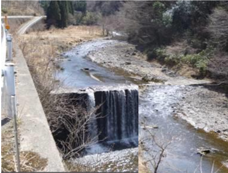
図-15 「本屋敷」上流の落差工
