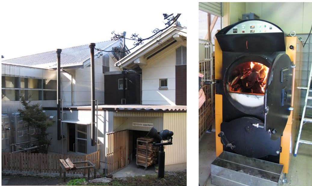
図 7 左：薪ボイラー建屋（いの町の温浴施設）右：薪ボイラー本体（須崎市の温浴施設）
