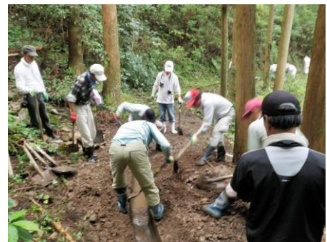
2012年8月28日水路の復旧
