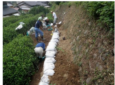
2012年10月11日 法面の土嚢づみ
