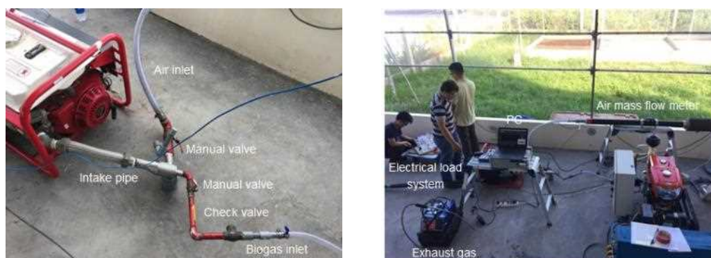
図 66 ：ベンチ実証サイトにて発電試験に用いたエンジン；(左) ガソリンあるいはバイオガスによる発電に用いたガソリンエンジン、(右) ディーゼルあるいはデュアルフュエルによる発電に用いたディーゼルエンジン（実証サイトにて、HCMUT の学生が実験を行っている。）
