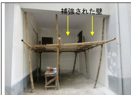
写真 28 フェロセメント工法にて補強された PWD HQ 建物 1 階部分
