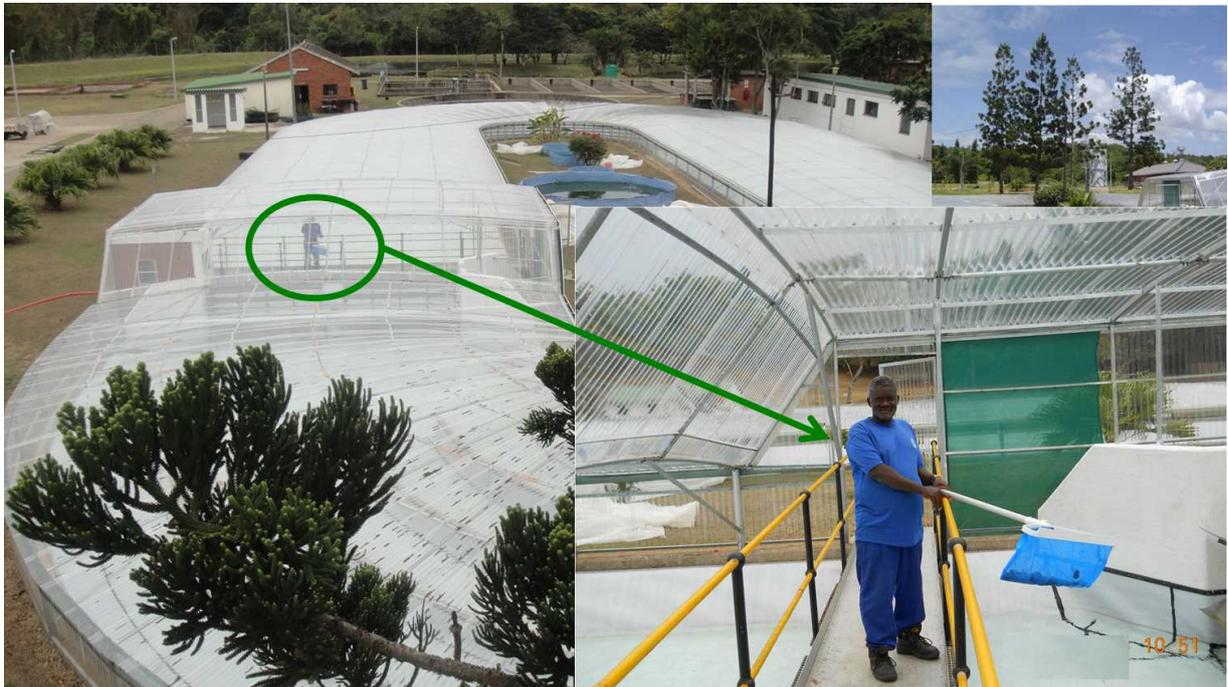
図 1-1 南アフリカ共和国 eThekweni 自治政府が管理する Kingsburgh 下水処理場内に、ダーバン工科大学が設置した、培養液重量 300ton の微細藻類培養プール (白色の屋根: 面積 1000m<sup>2</sup>) と、培養液重量 3ton の微細藻類培養プール (中央上部の水色の小型プール)
