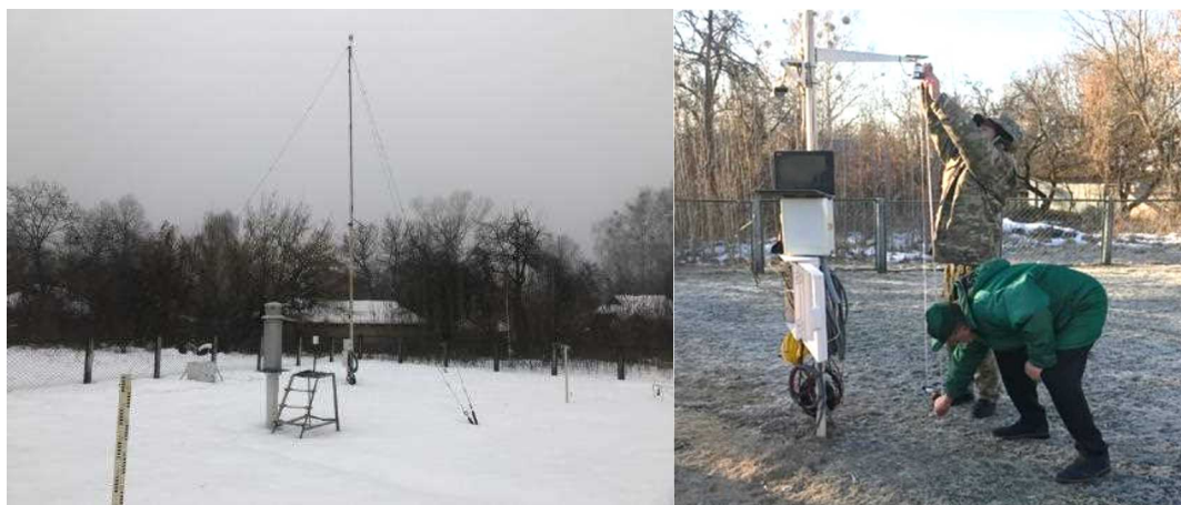
図 3-1 チョルノービリ規制区域内に設置された気象測器（左）。右は積雪深計の設置高の確認作業の様子。
