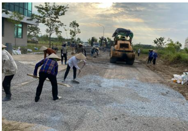
HUCE ハナムキャンパスでのパイロット試験（実規模駐車場施工）。左：施工中の様子、右：施工後の上空からの様子（赤褐色が再生材透水舗装区で、灰色が通常の天然資材コンクリート舗装区）
