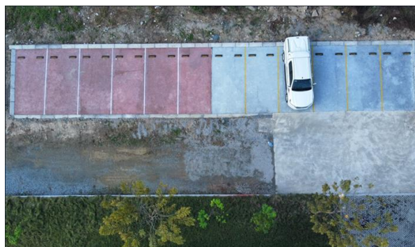
HUCE ハナムキャンパスでのパイロット試験（実規模駐車場施工）。左：施工中の様子、右：施工後の上空からの様子（赤褐色が再生材透水舗装区で、灰色が通常の天然資材コンクリート舗装区）
