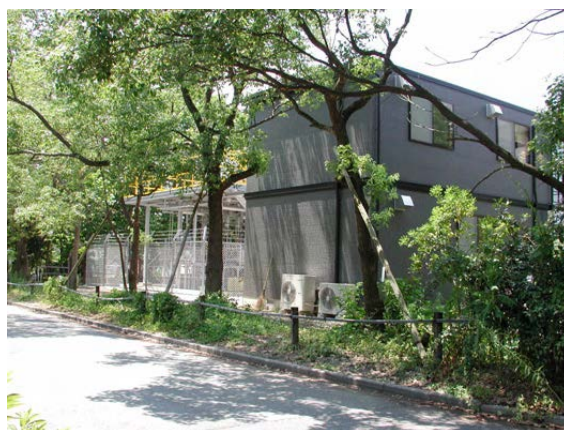
図 3.1.17 相分離系変換システムプラント (機材・配電盤収納庫, 研究棟)
