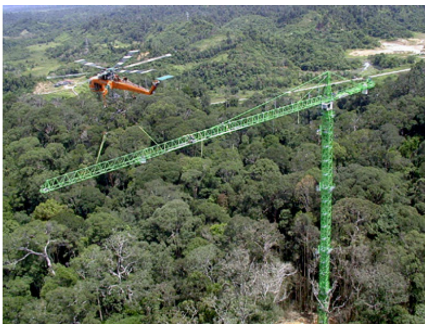
写真 1. 建設最終段階の林冠クレーン。2001 年 3 月。
