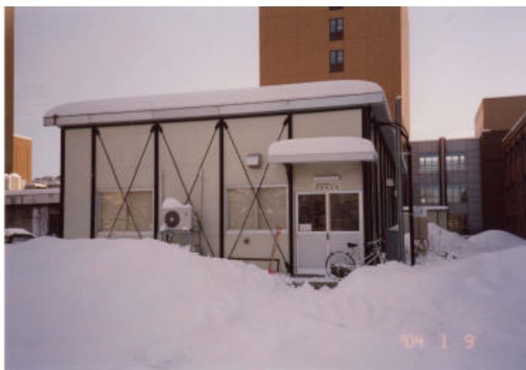
C R E S Tのために設置したプレハブ実験室
