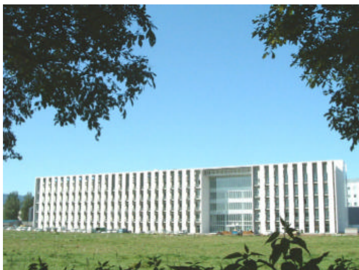
平成15年11月に触媒化学研究センターが入った創成科学研究棟
